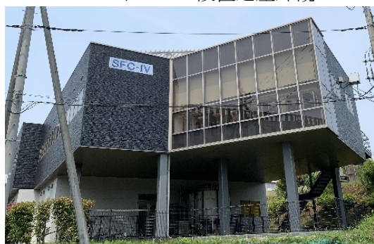
<スマートルーム設置建屋外観>
