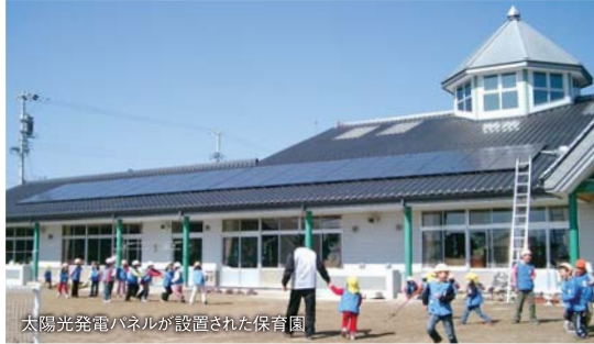
太陽光発電パネルが設置された保育園
