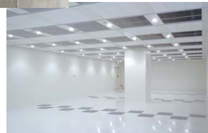
二期工事で増設されたコロケーションルーム(パワー・アンド・IT)
