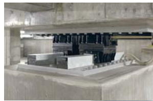
パワー・アンド・ITの 免震装置
